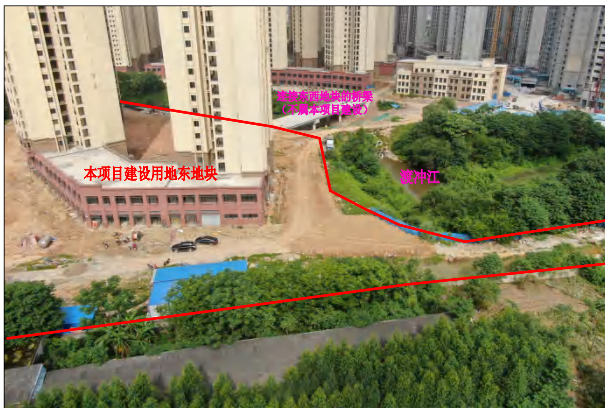
项目用地东地块北面现状，主体建筑已建成，现状进行排水、道路等附属设施建设
