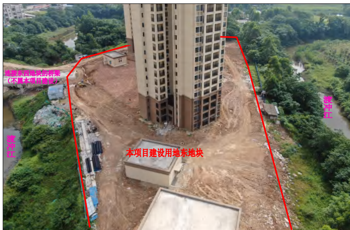
项目用地东地块中部现状，主体建筑已建成，现状进行排水、道路等附属设施建设
