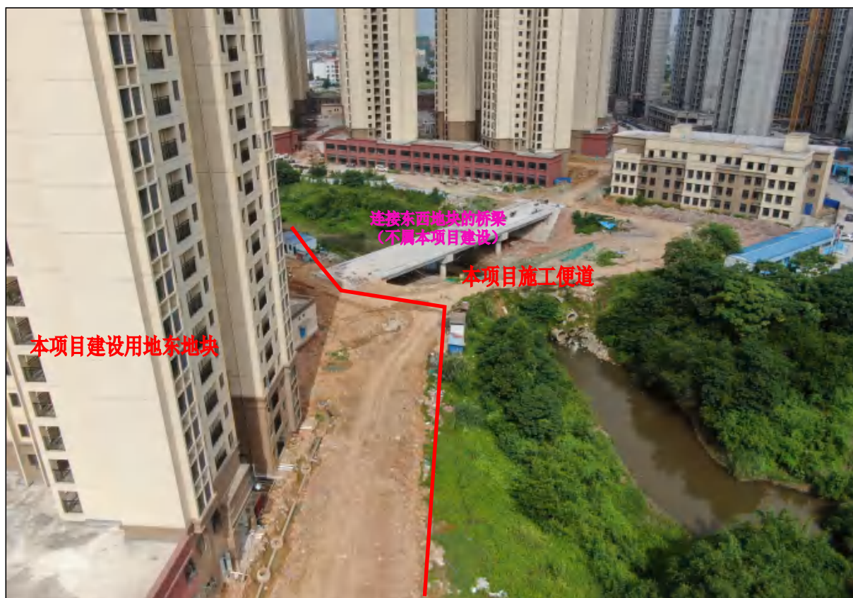
项目用地东地块北面现状，主体建筑已建成，现状进行排水、道路等附属设施建设
