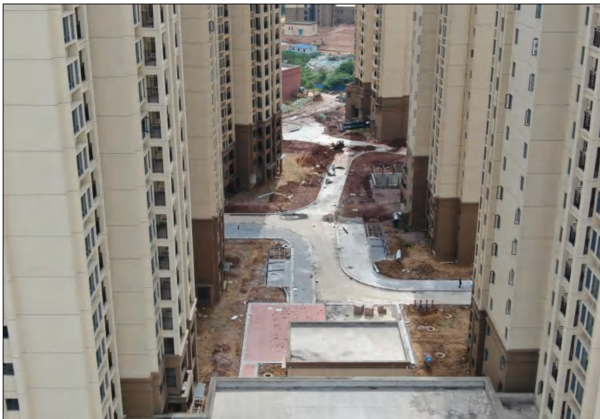
项目用地西地块中部现状，现状进行道路、铺装等附属设施建设
