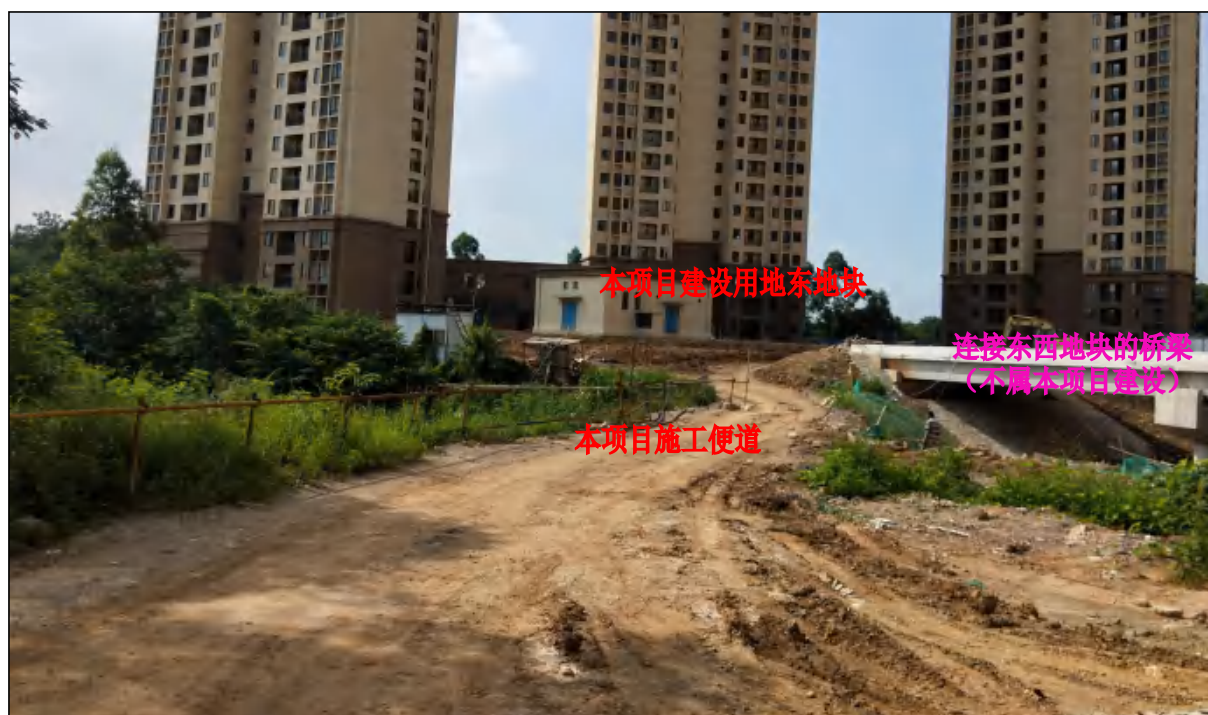
本项目设置施工便道现状
