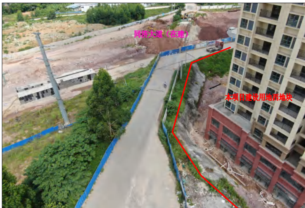
项目用地西地块南面现状，主体建筑已建成，西南角形成高约 2m 的临时边坡，坡面已喷砼防护
