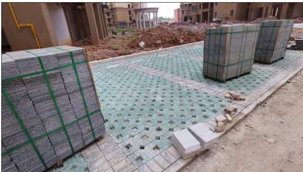
西地块铺透水砖现状
