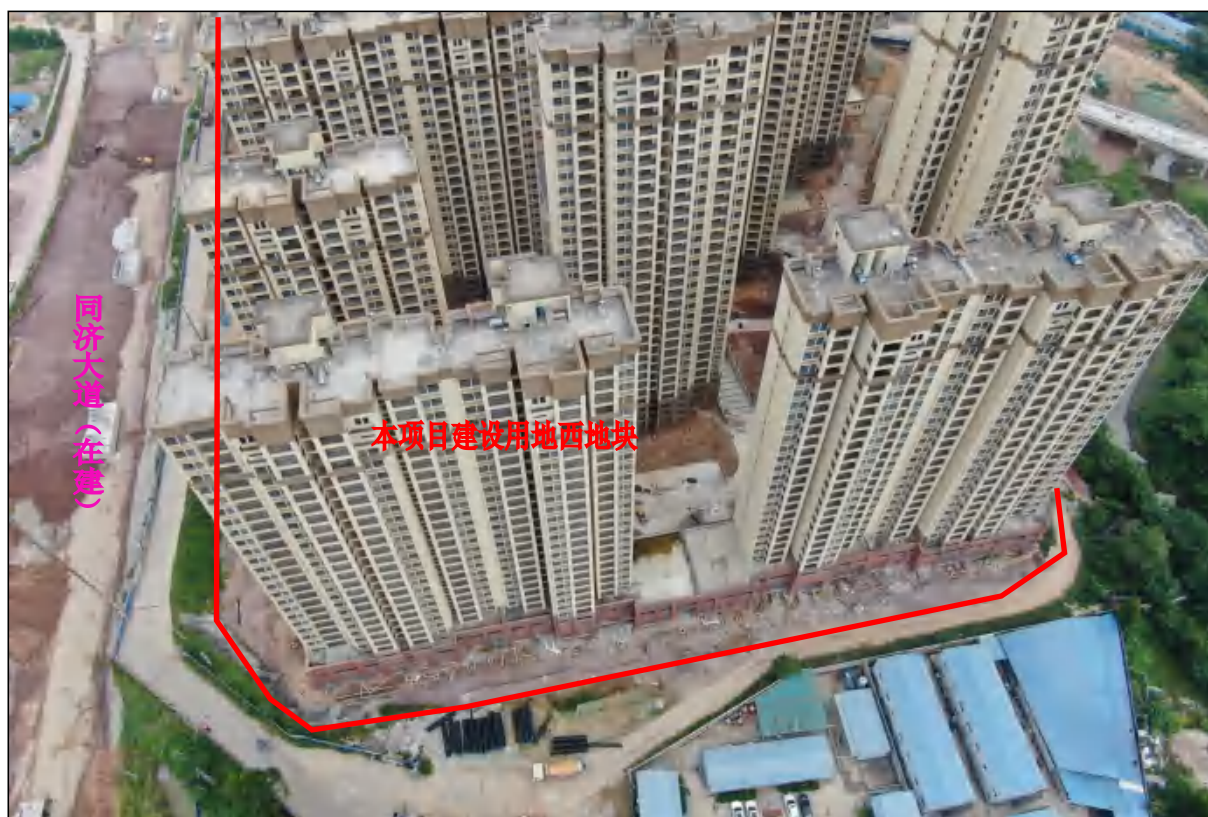
项目用地西地块南面现状，主体建筑已建成，现状进行排水、道路、绿化等附属设施建设
