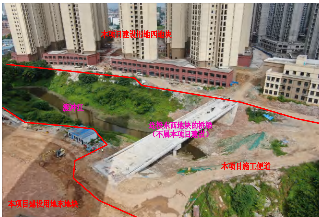
连接东西地块的桥梁在建现状，本项目设置施工便道现状
