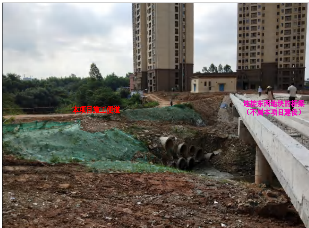
连接东西地块的桥梁在建现状，本项目设置施工便道现状，路基边坡已采取密目网临时覆盖
