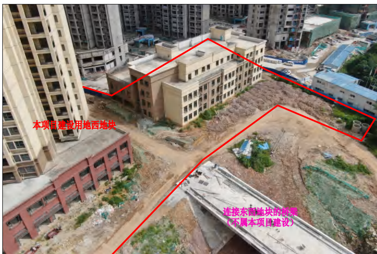
项目用地西地块东北面现状，主体建筑已建成，现状进行排水、道路等附属设施建设
