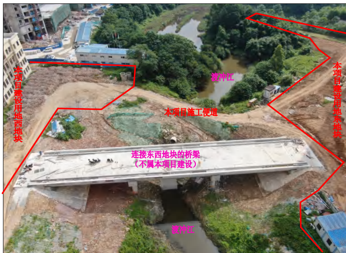
连接东西地块的桥梁在建现状，本项目设置施工便道现状
