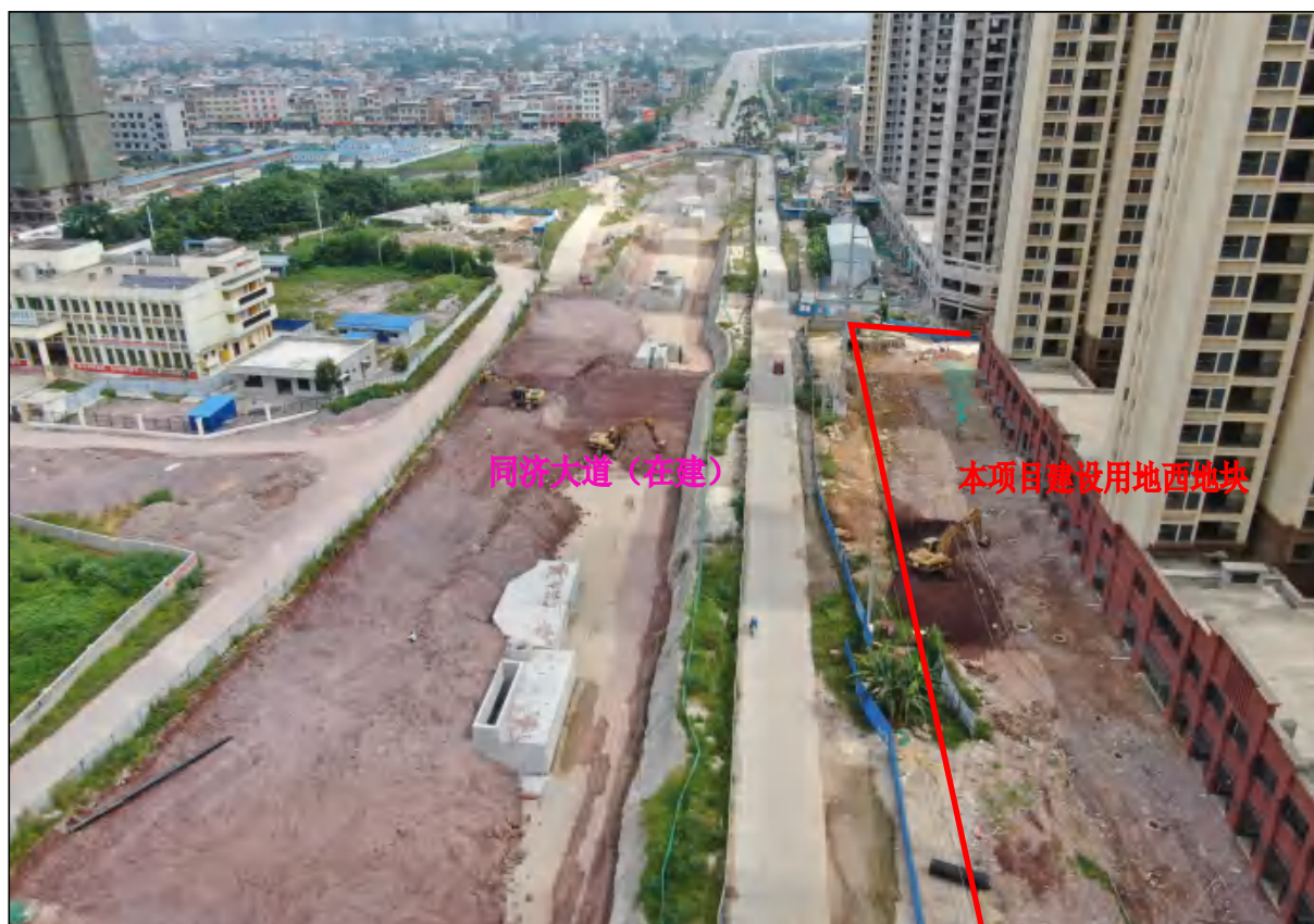
项目用地西地块西面现状，现状进行排水、道路等附属设施建设
