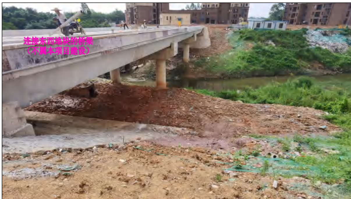
连接东西地块的桥梁在建现状
