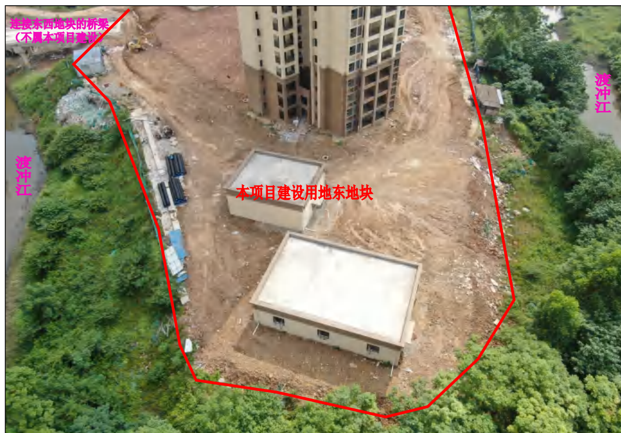
项目用地东地块南面现状，主体建筑已建成，现状进行排水、道路等附属设施建设
