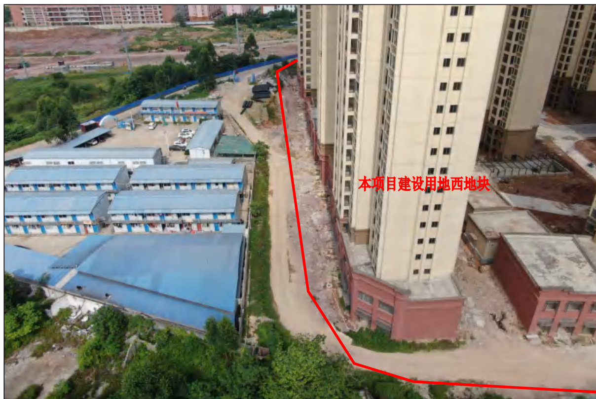
项目用地西地块南面现状，主体建筑已建成，现状进行排水、道路等附属设施建设
