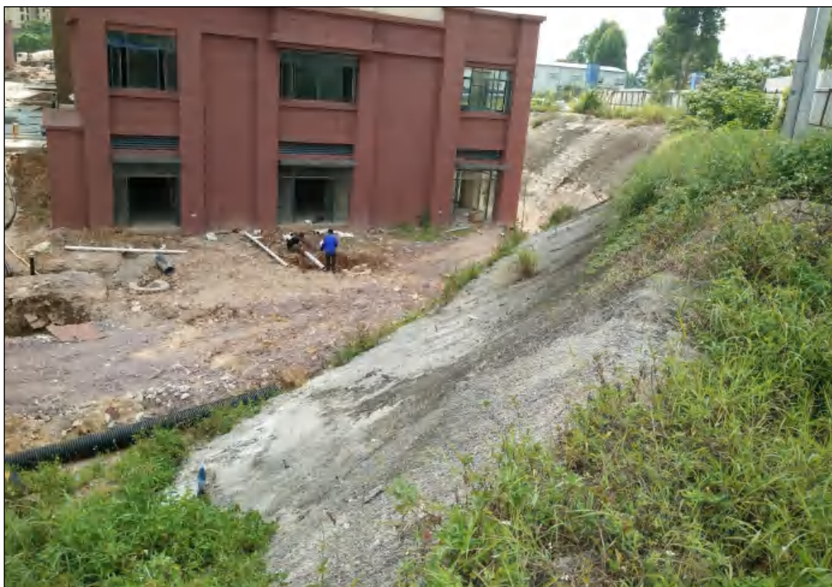
西地块西南角用地临时边坡现状，坡面已喷砼防护，无较大水土流失
