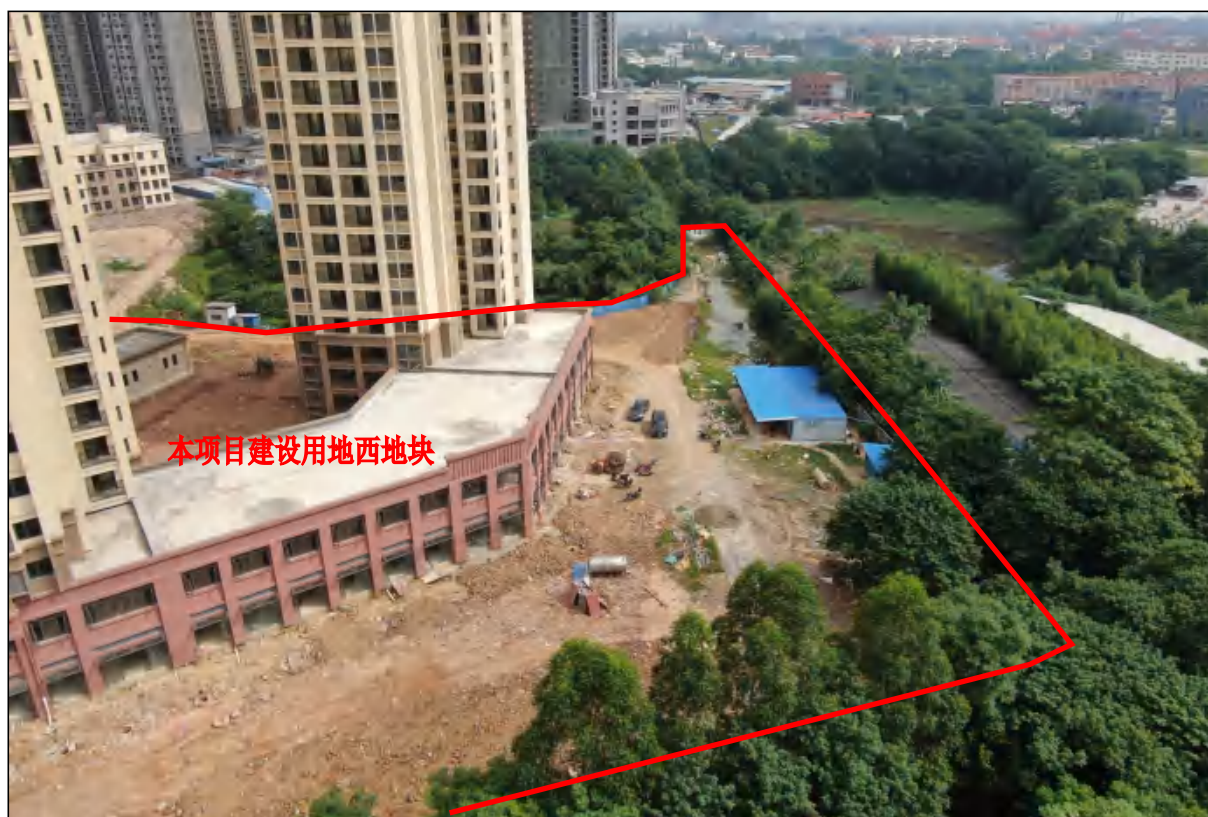
项目用地东地块东北面现状，主体建筑已建成，现状进行排水、道路等附属设施建设
