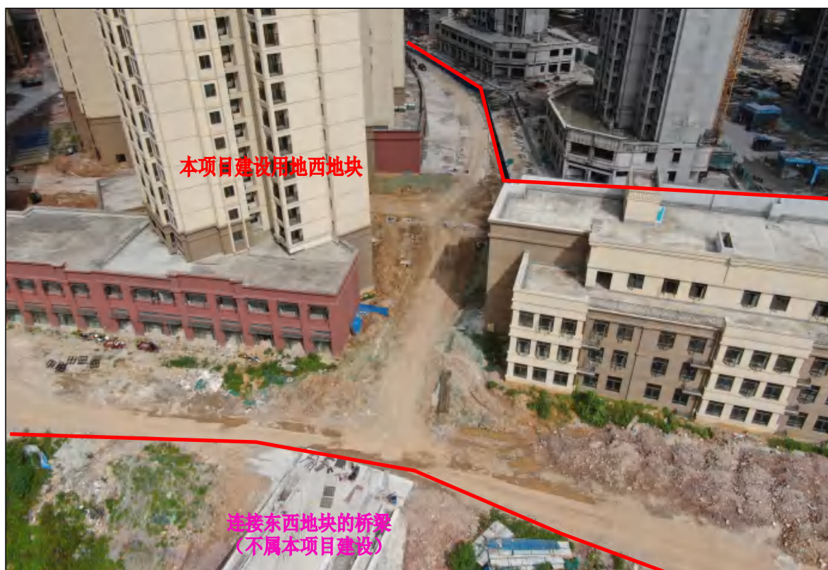
项目用地西地块东北面现状，主体建筑已建成，现状进行排水、道路等附属设施建设
