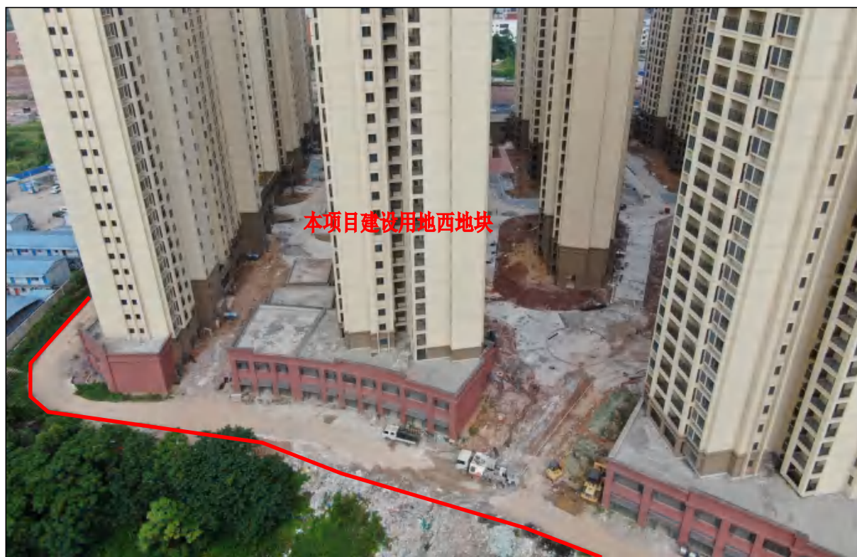
项目用地西地块东南面现状，主体建筑已建成，现状进行排水、道路等附属设施建设
