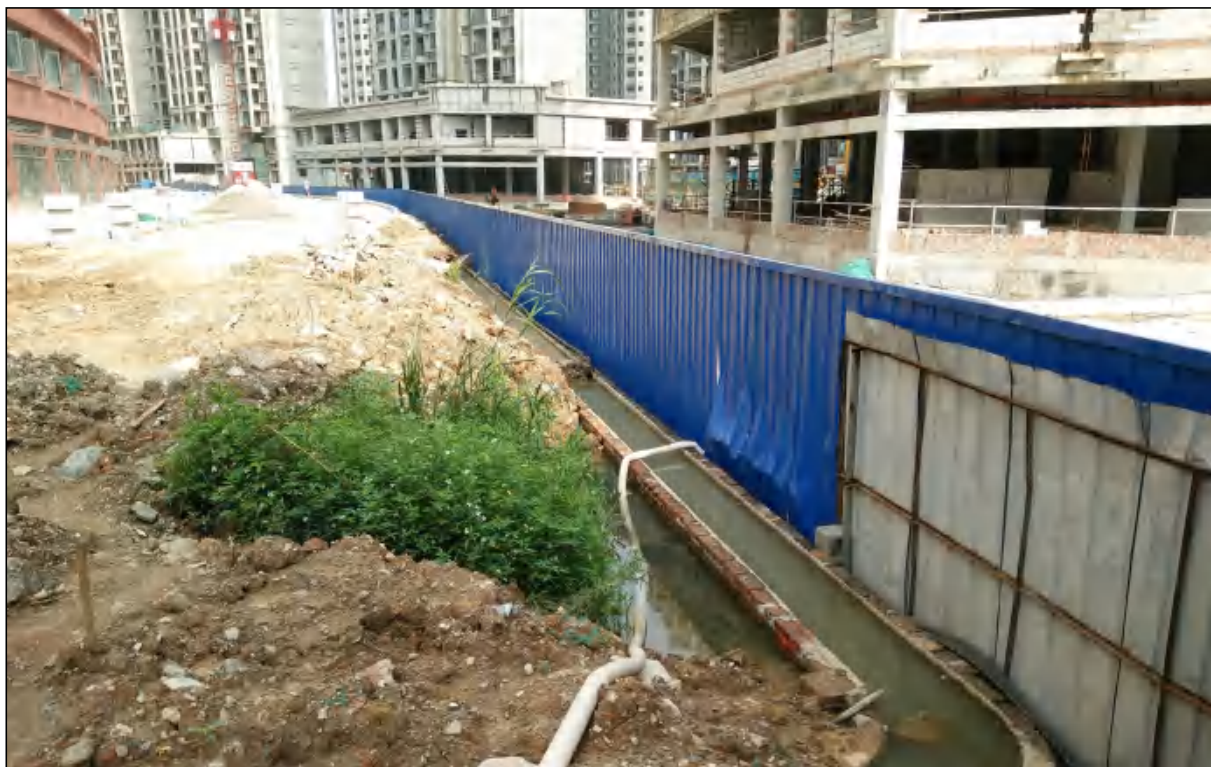
西地块北面浆砌砖排水沟现状
