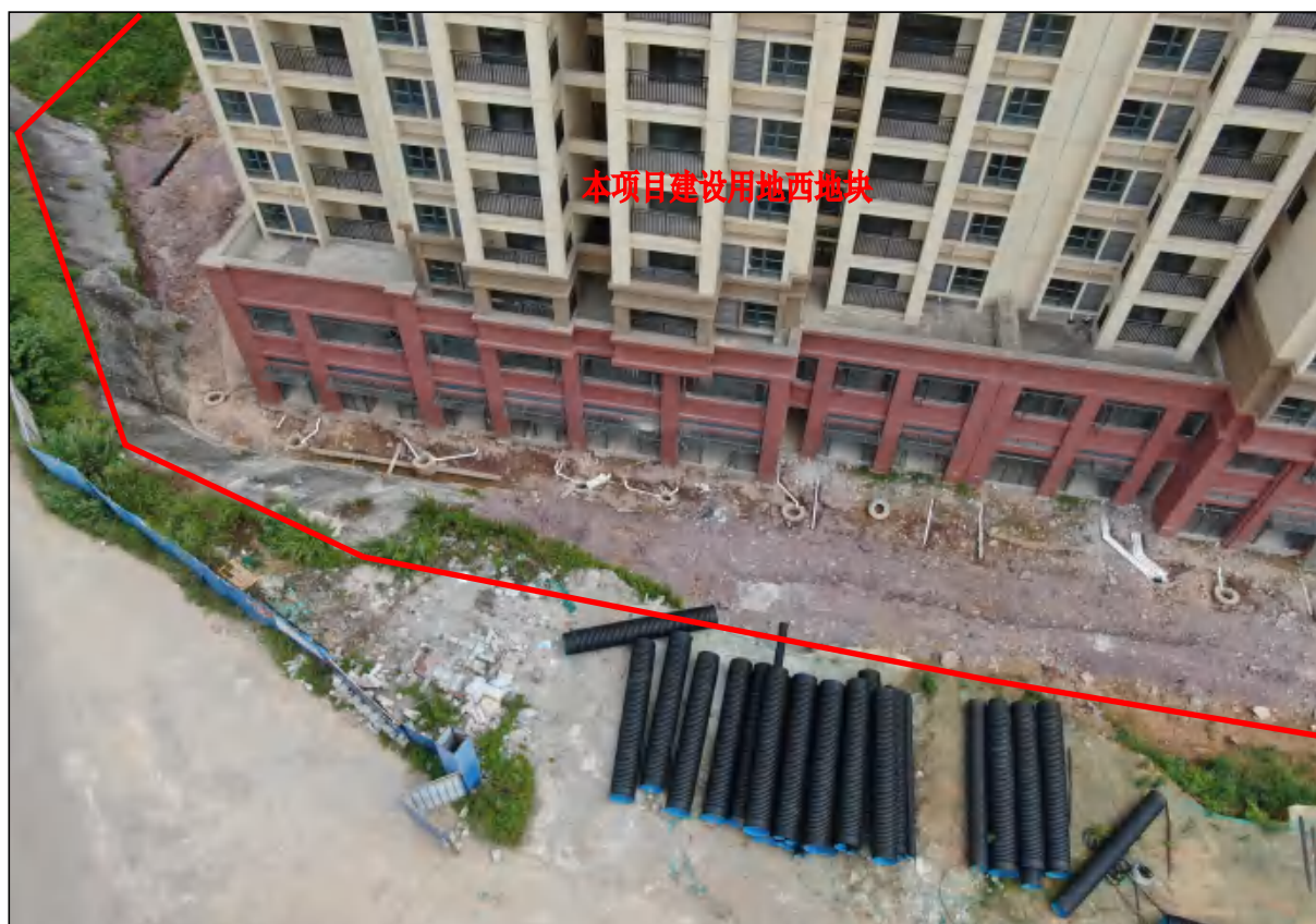
项目用地西地块南面现状，主体建筑已建成，现状进行排水、道路等附属设施建设
