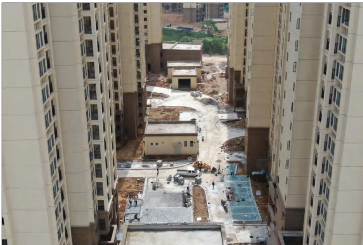
项目用地西地块中部现状，现状进行道路、铺装等附属设施建设
