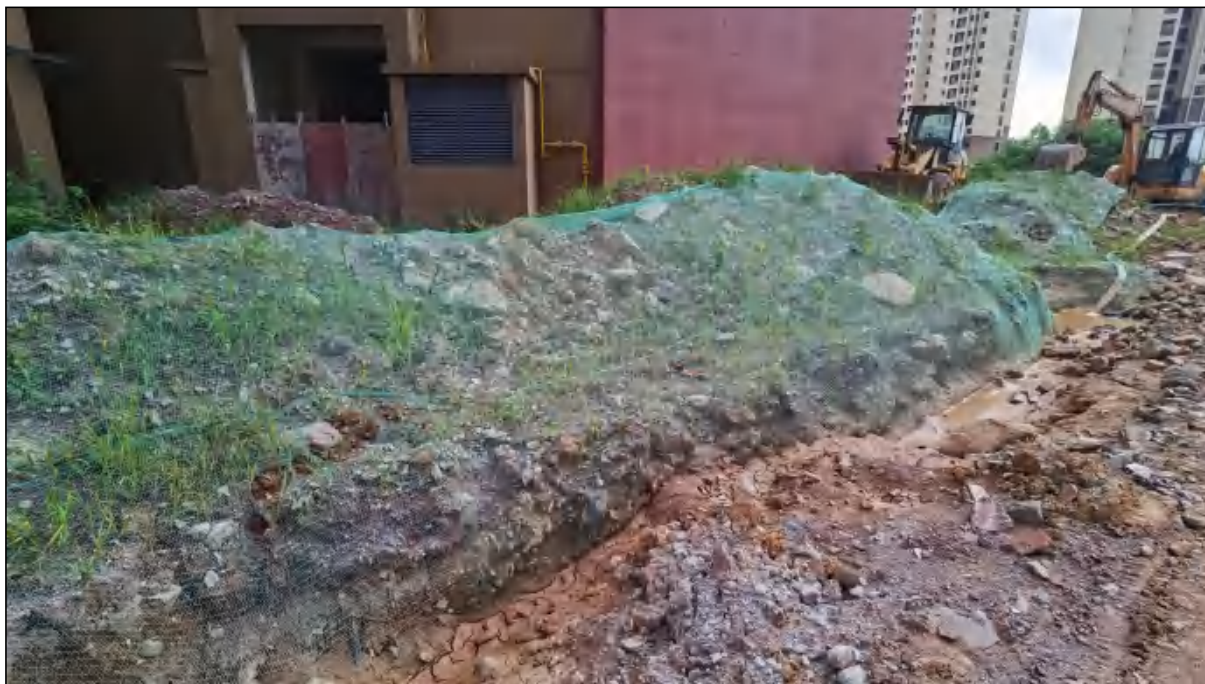
西地块裸露地表临时覆盖密目网现状
