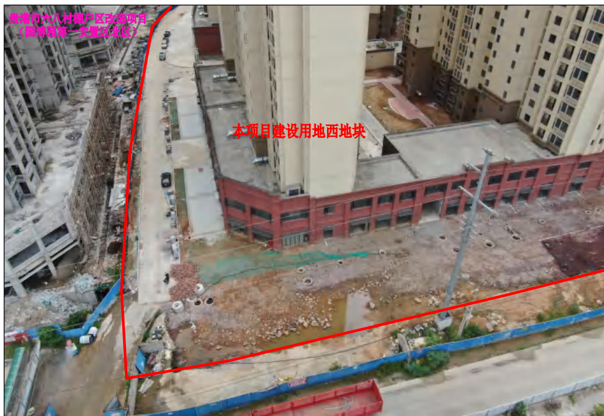
项目用地西地块西北面现状，现状进行排水、道路等附属设施建设
