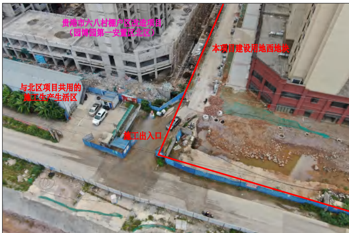
项目用地西地块西北角施工出入口现状
