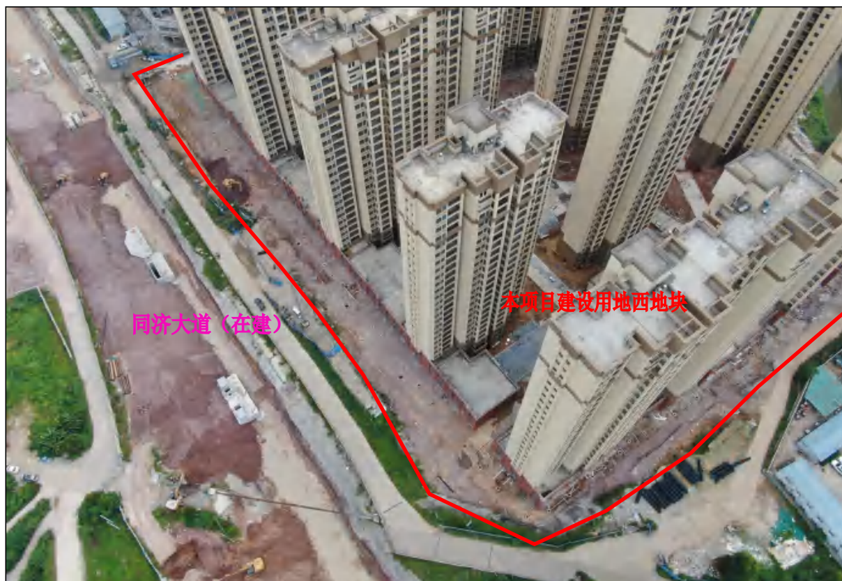
项目用地西地块南面现状，主体建筑已建成，现状进行排水、道路、绿化等附属设施建设
