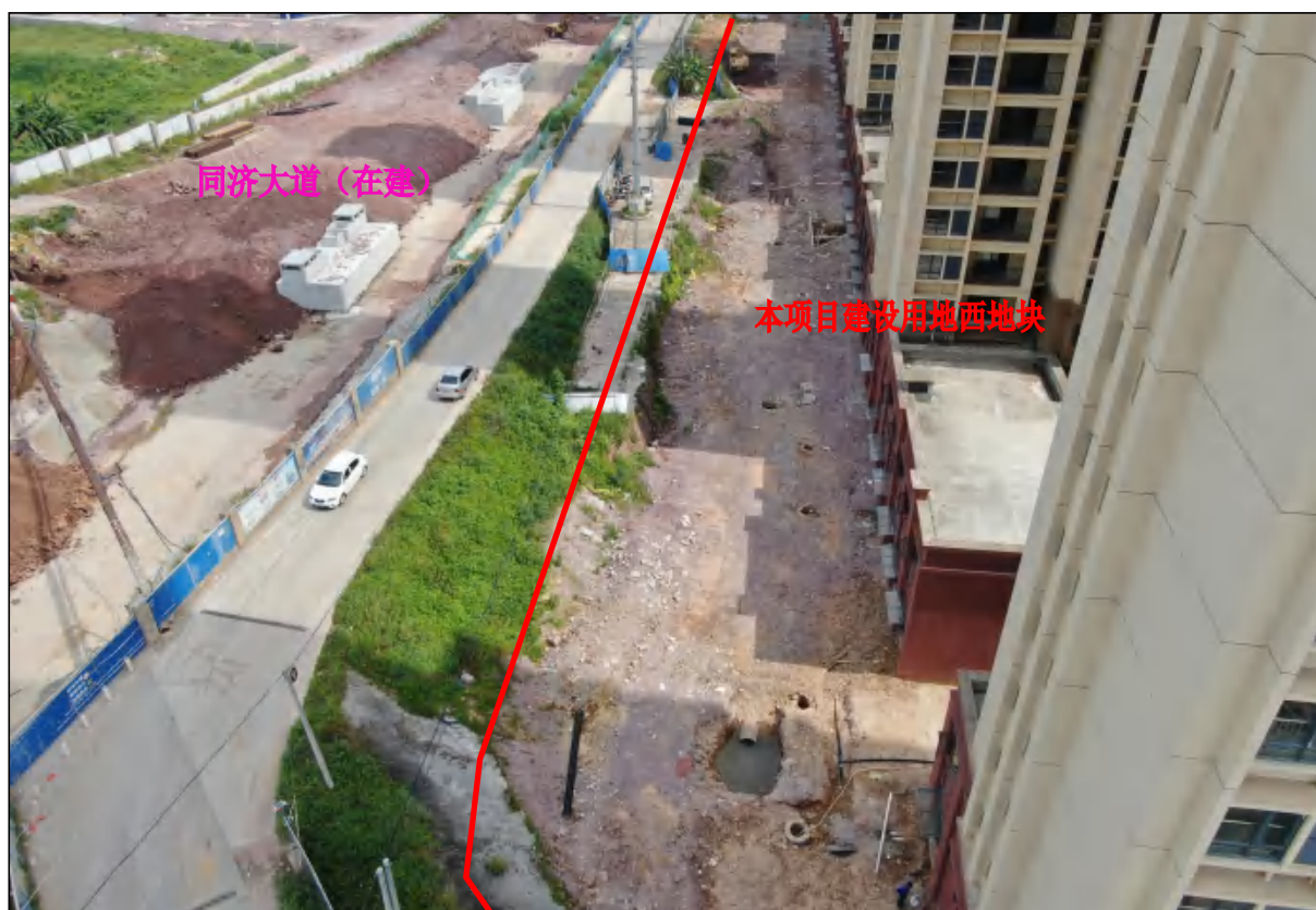
项目用地西地块西南面现状，现状进行排水、道路等附属设施建设
