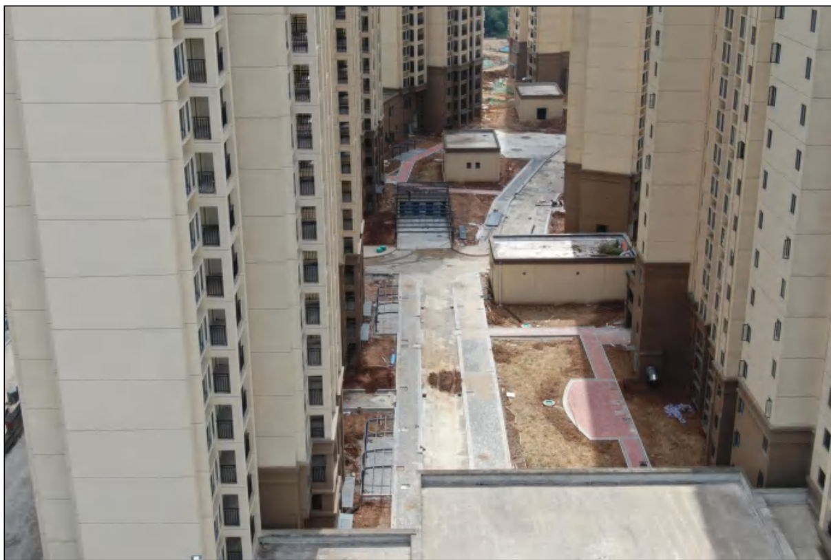
项目用地西地块北面现状，现状进行道路、铺装等附属设施建设
