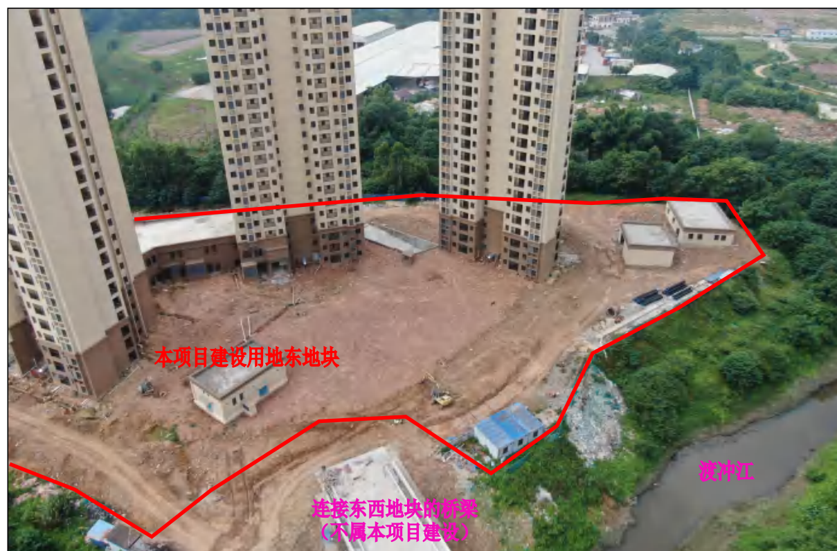
项目用地东地块西面现状，主体建筑已建成，现状进行排水、道路等附属设施建设
