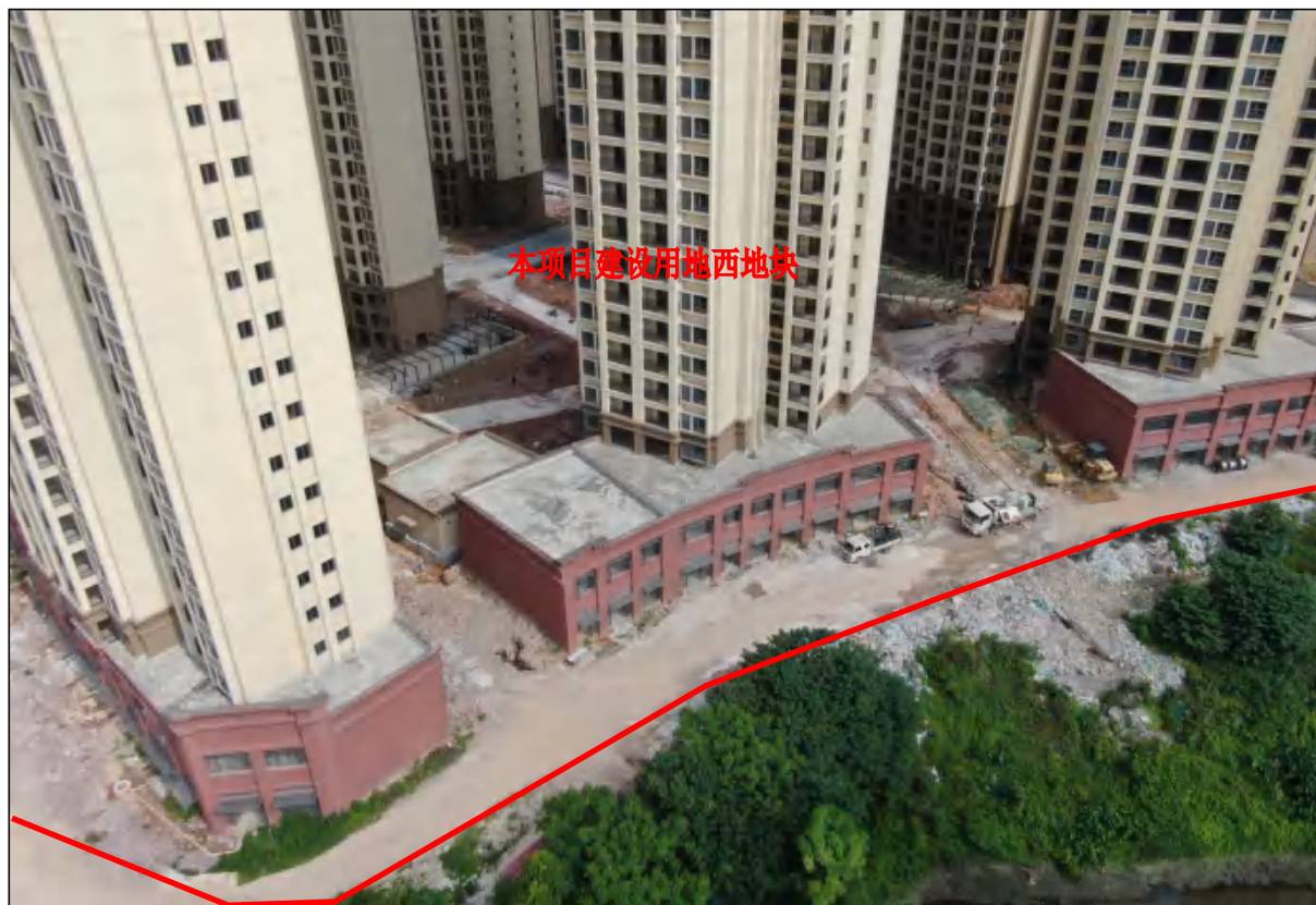
项目用地西地块东面现状，主体建筑已建成，现状进行排水、道路等附属设施建设
