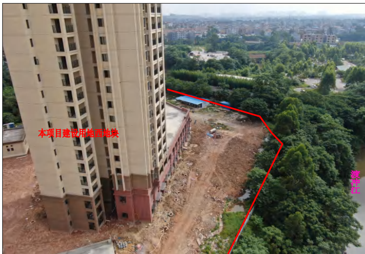
项目用地东地块东面现状，主体建筑已建成，现状进行排水、道路等附属设施建设
