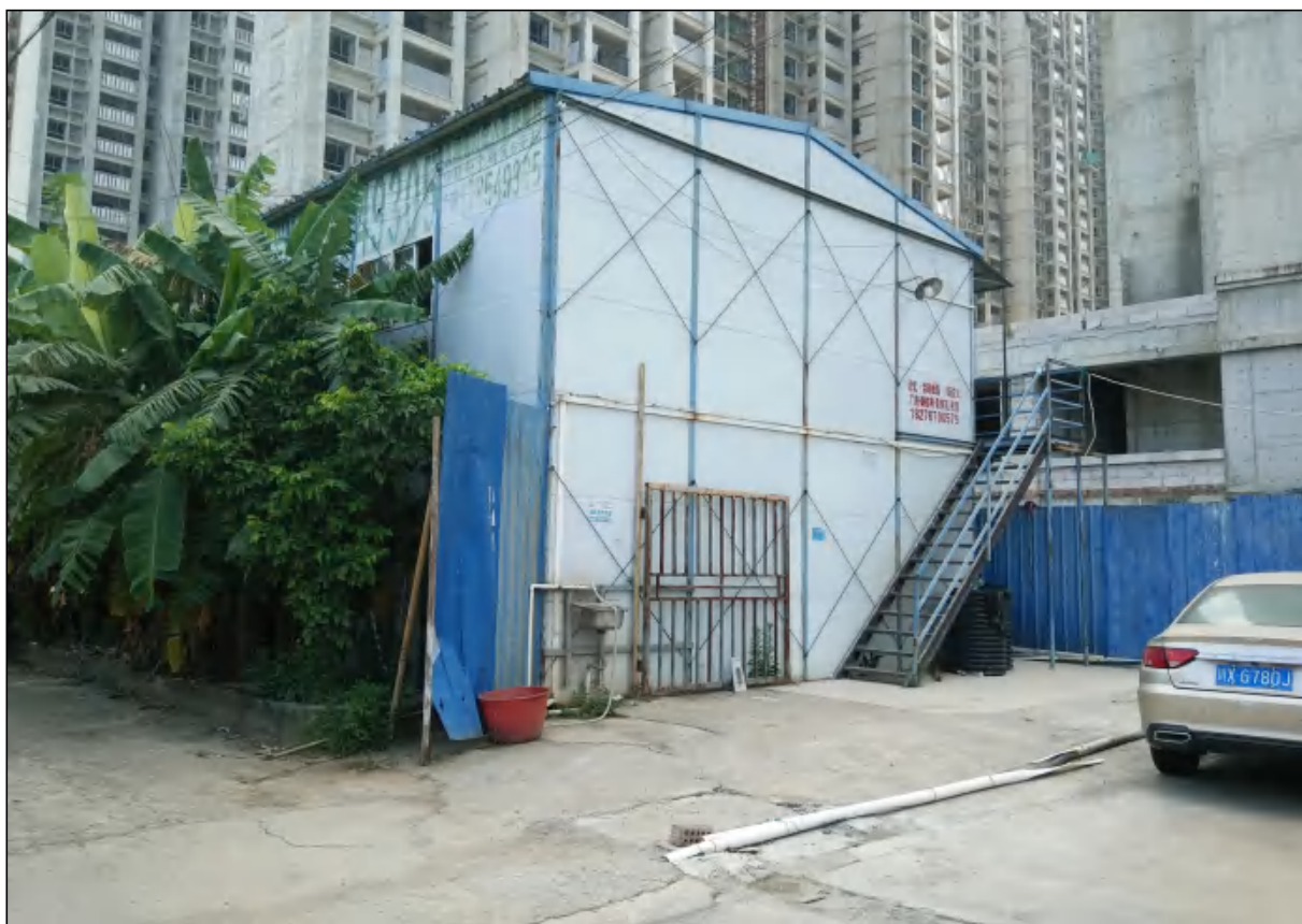
与北区共用施工生产生活区现状，地面已硬化，无较大水土流失
