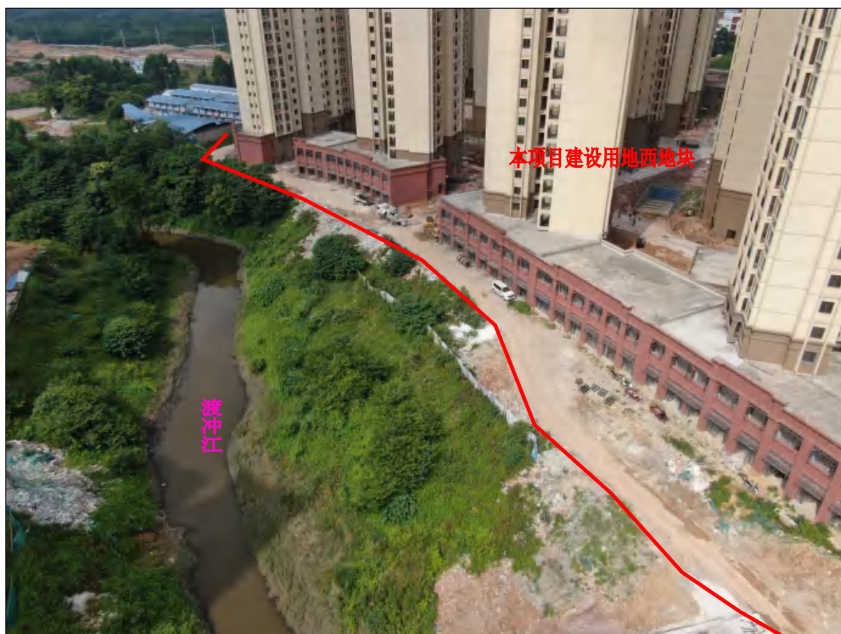
项目用地西地块东面现状，主体建筑已建成，现状进行排水、道路等附属设施建设
